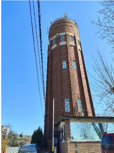
Рис. 20. Водонапірна вежа , вул. Пасічна, 67 (світлина – Л. Котик, березень 2025 р.)
